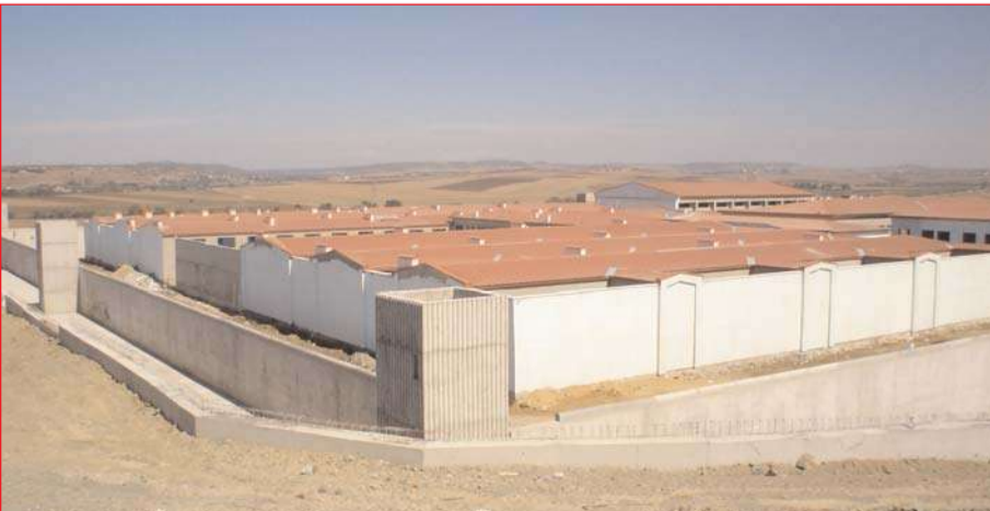
İnşaatı bitme aşamasına gelen Silivri Ceza İnfaz Kurumları Kampüsü
